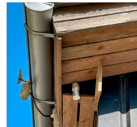
En vejrstation, købt i detailhandelen, blev opsat under udhængen på greenkeepergården.
