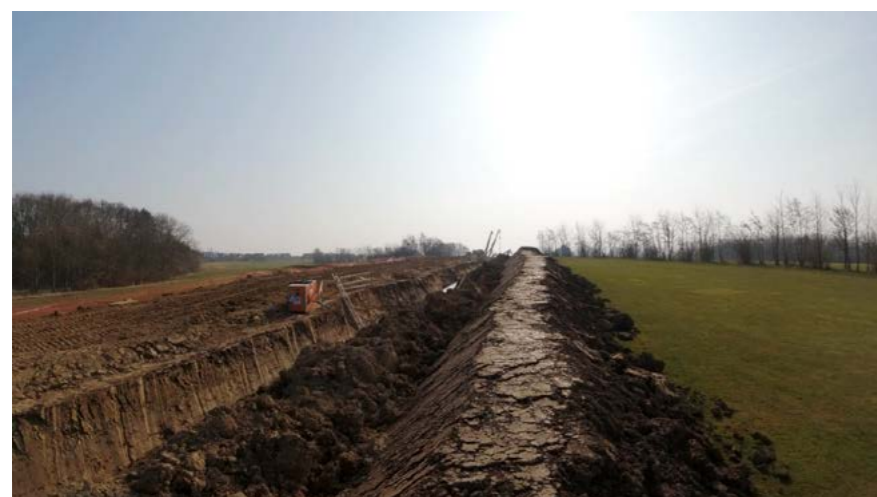
FOTO 4: Der blev lavet et langt og dybt ar hen over ni huller på Golfbanen Lillebælt, da Baltic Pipe blev lagt ned i jorden i foråret 2022. Ledningen skulle graves 2,30 meter ned i jorden.
