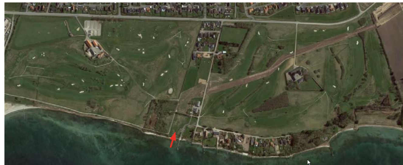
FOTO 3: Golfklubben Lillebælt set fra oven af. Her ses det tydeligt, hvor Baltic Pipe er gravet ned i den ene halvdel af banen. Ni huller måtte lukkes for spil. Ved den røde pil kommer Baltic Pipe ind på golfbanen ude fra Fænøsund.
